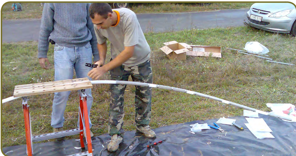
47. ábra: CMT kút szerelése
