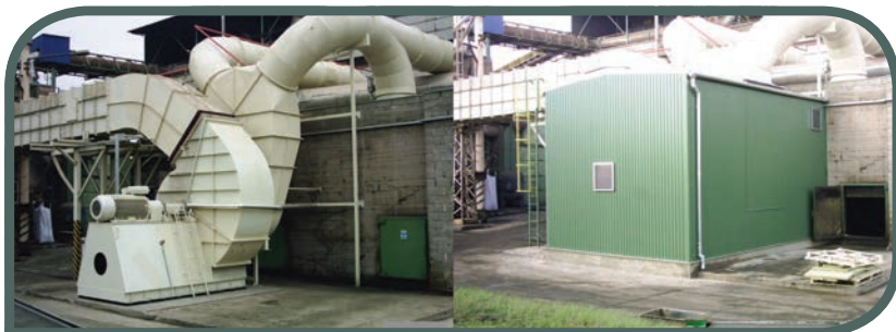
6.4.5. ábra Elszívó ventilátor esztétikus megjelenésű tokozása – zajcsökkenés előtt és után
