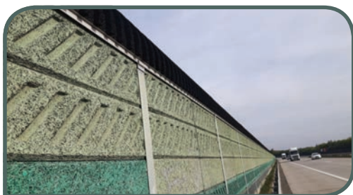
6.4.1. ábra Zajvédő fal hatékonyságának növelése – elnyelő „cső” a fal felső élén (M0-ás autópályán)
