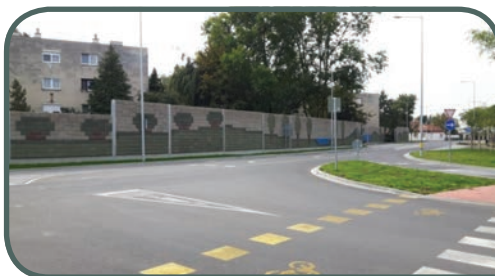
6.4.2. ábra Környezetbe illő zajvédő fal kiala- kítása (Győr)
