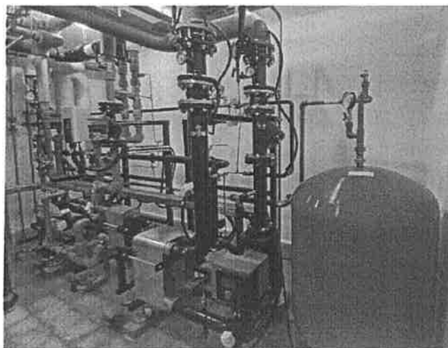
19. ábra: Modul rendszerű hőközpont
