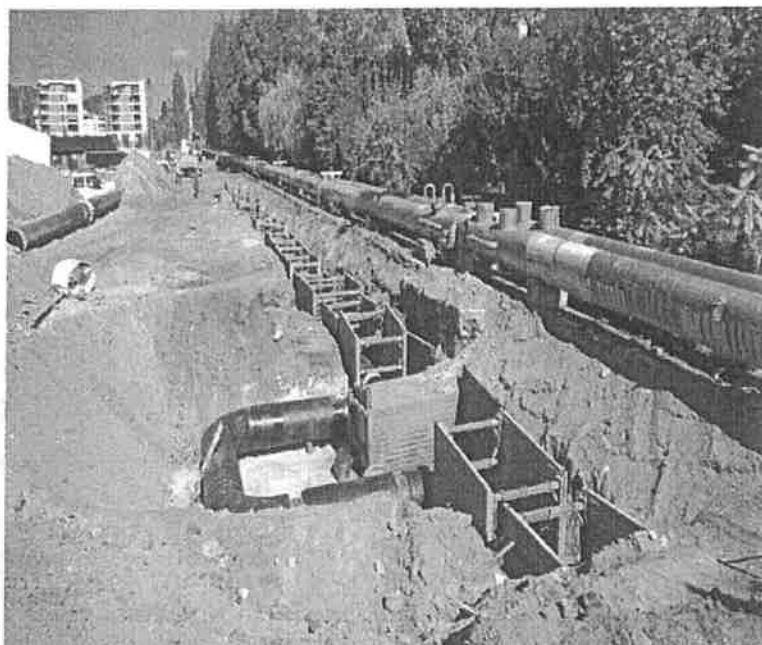
21. ábra: Épülő távvezeték
