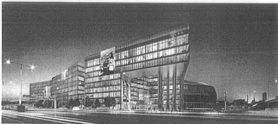
23. ábra: A távhővel ellátott Telekom székház
