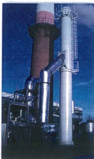
3. kép: Rákoskeresztúri fűtőműben létesült hőhasznosító valamint a régi és az új kémény
