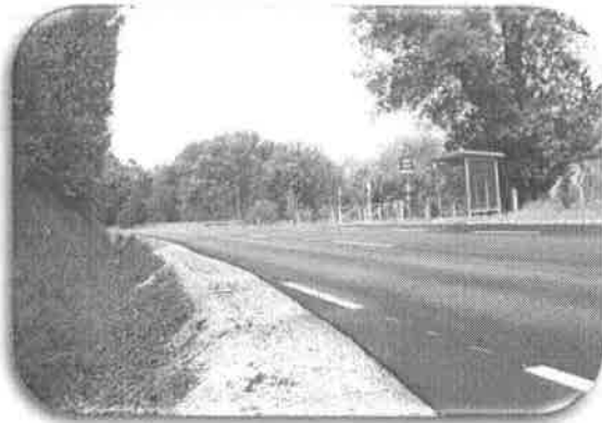
Megtörtént a Nagyvenyimre vezető út felújítása
