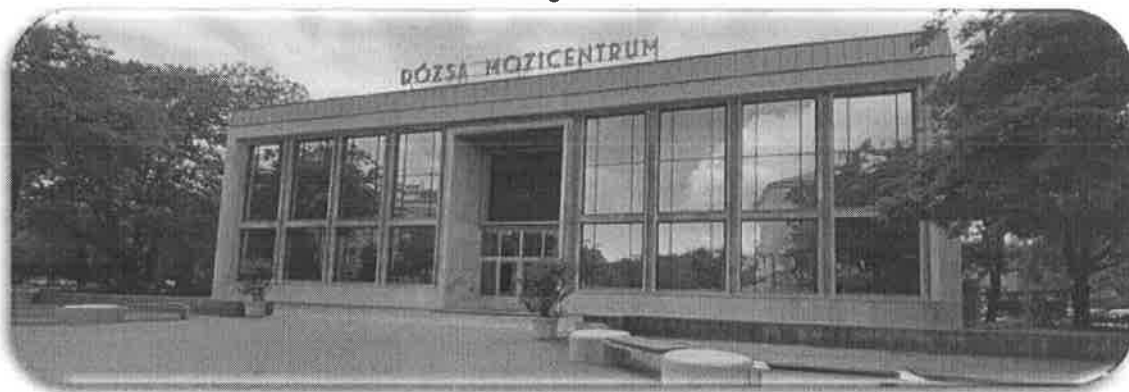
Dózsa Mozicentrum az energetikai korszerűsítést követően
