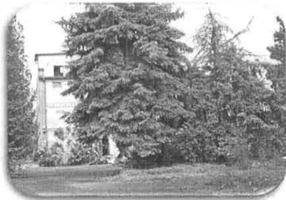
A Mondbach-kúria felújítási munkálatai jelenleg is zajlanak
