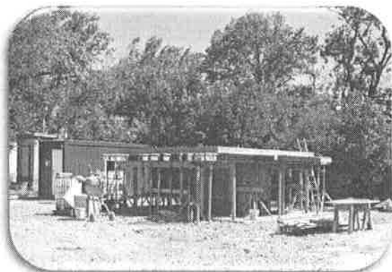
A csápos kút felszín feletti részének építése
