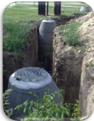
Elkezdődött a partvédőmű vízét átvezető csőhálózat kivitelezése.
