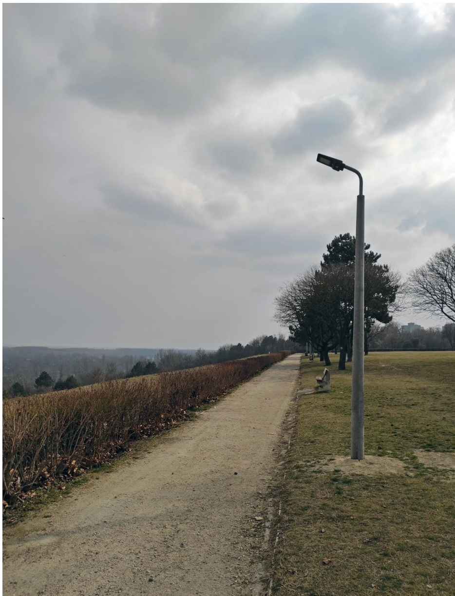
Napelemes közvilágítás kiépítése a Duna-parton
